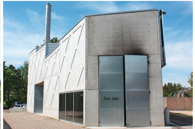
„Feuer-Atelier“ mit Rauchgasreinigung, CH-Zürich
