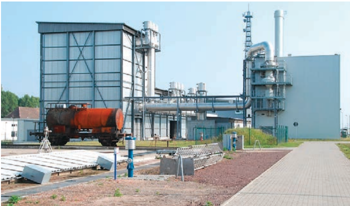
Realbrandhalle mit Rauchgasreinigung, D-Magdeburg
