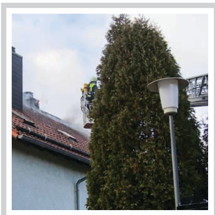
Dachstuhlbrand in Wiesau.
